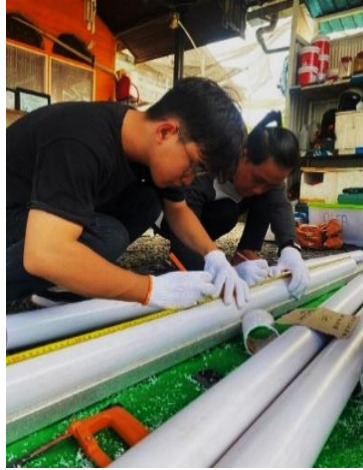
Gambar 5. Proses pengukuran pipa yang akan digunakan
